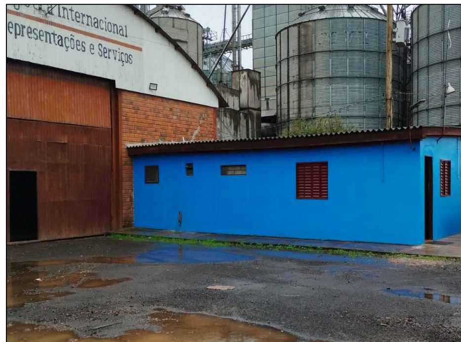
01. Entrada do galpão
