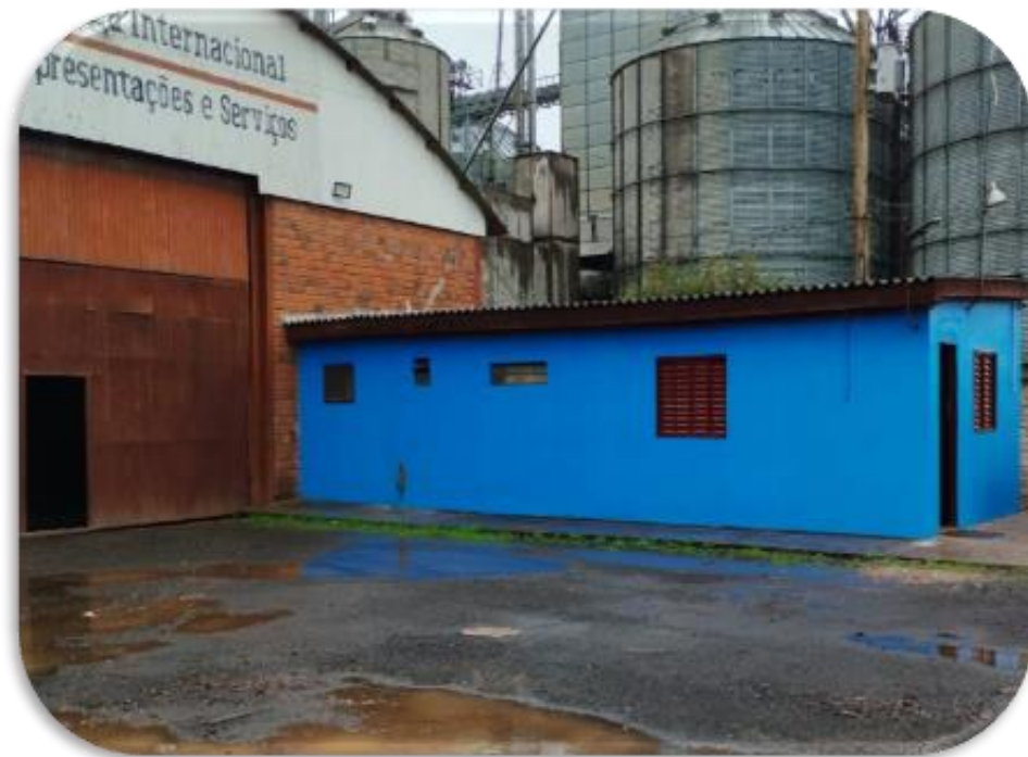
01. Entrada do galpão
