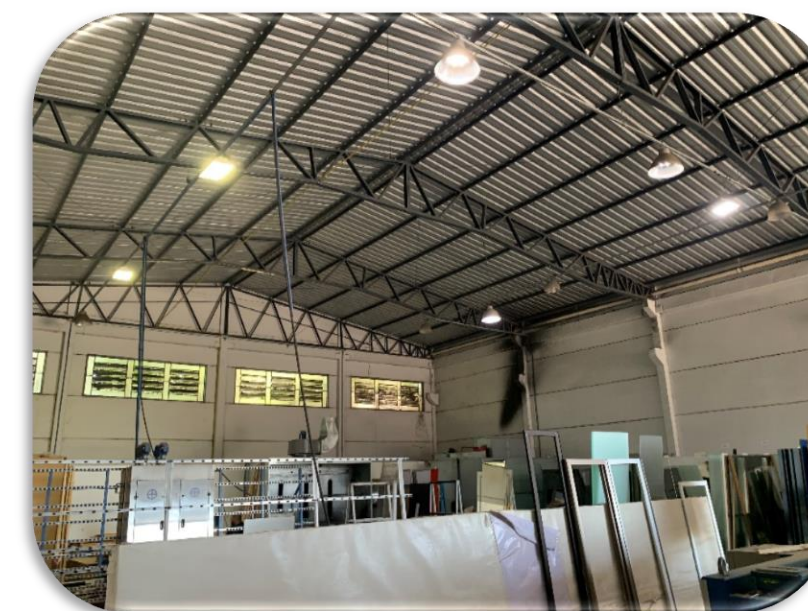
05. Interior da sede da empresa
