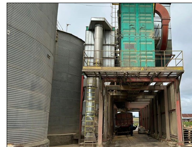
06. Silos de armazenagem
