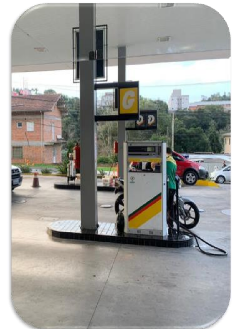
04. Bomba de abastecimento
