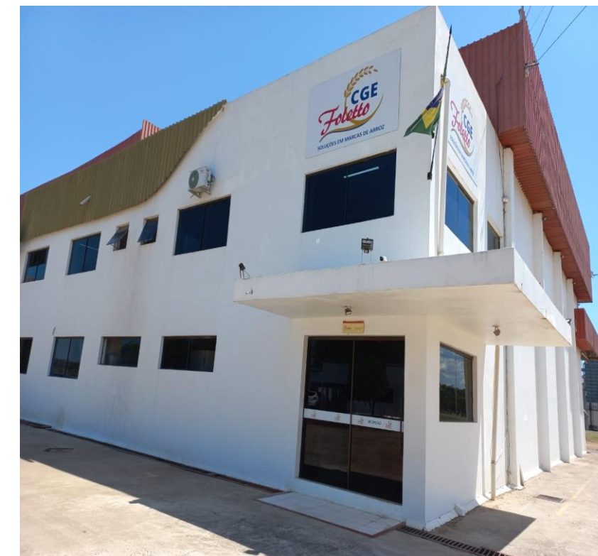
03* . Parte externa da sede da empresa
