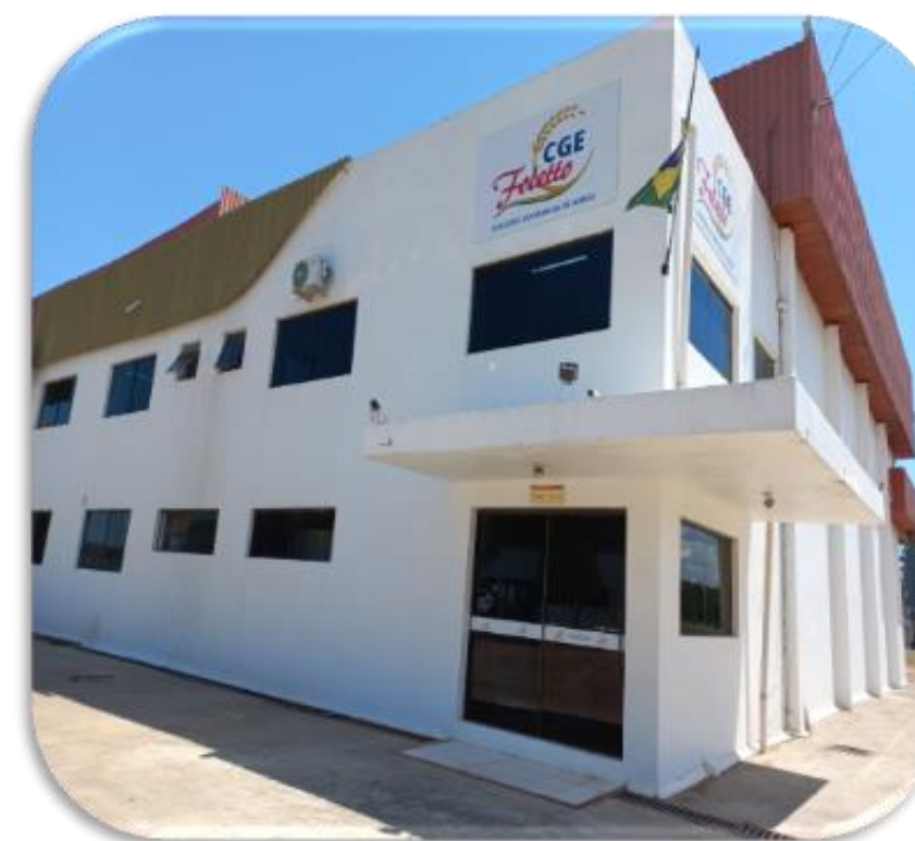
03* . Parte externa da sede da empresa
