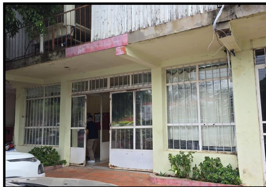
01. Fachada da Fábrica
