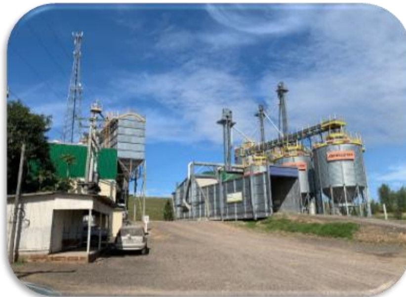
01. Área externa da sede
