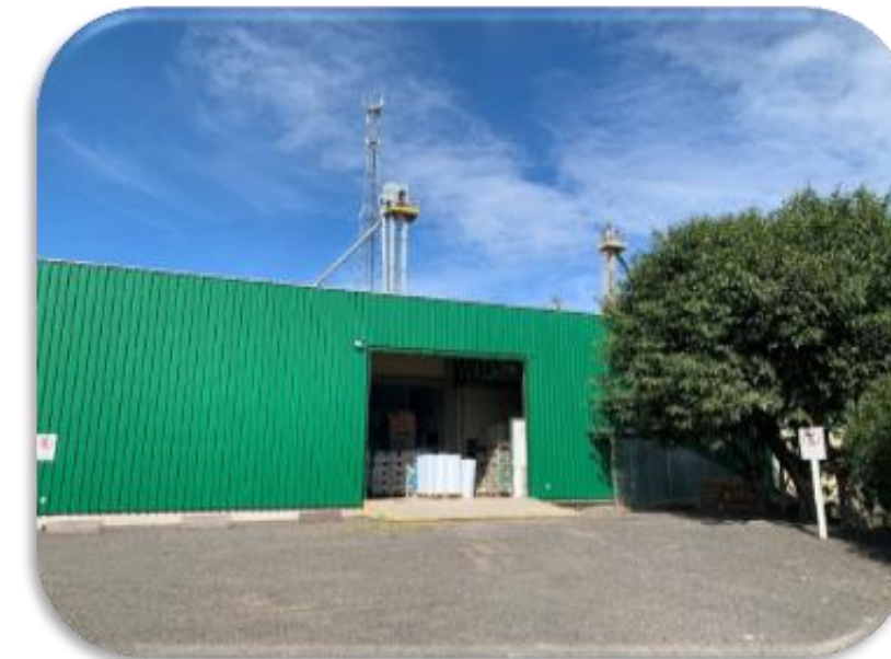
03. Área externa da sede
