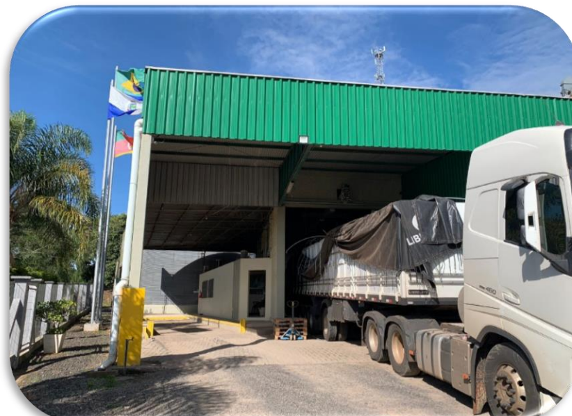
04. Área de carga e descarga
