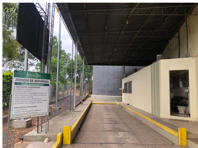
04. Área de carga e descarga
