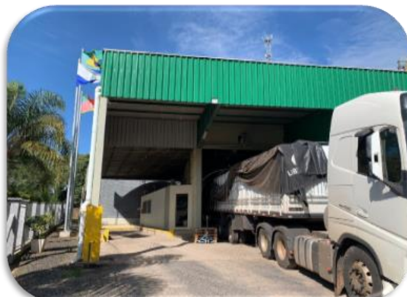
04. Área de carga e descarga
