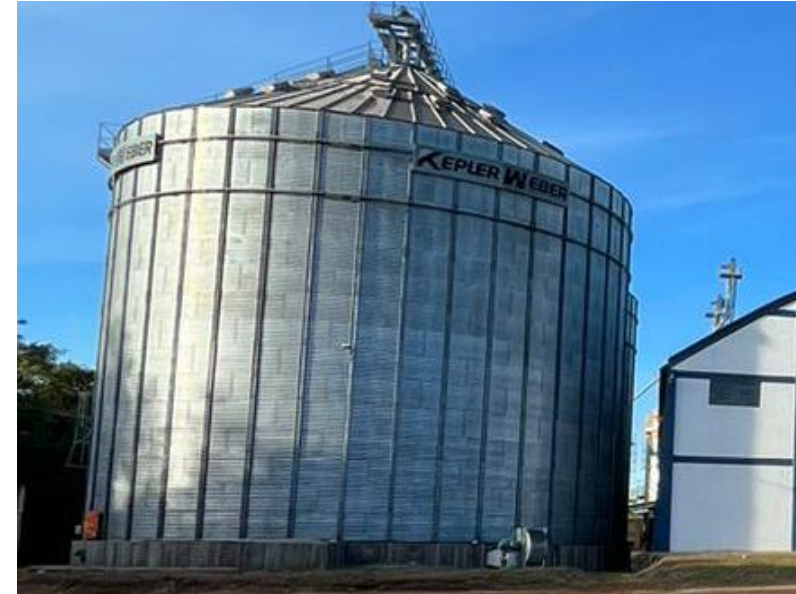
05. Silos de armazenamento de grãos
