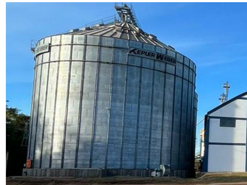
05. Silos de armazenamento de grãos
