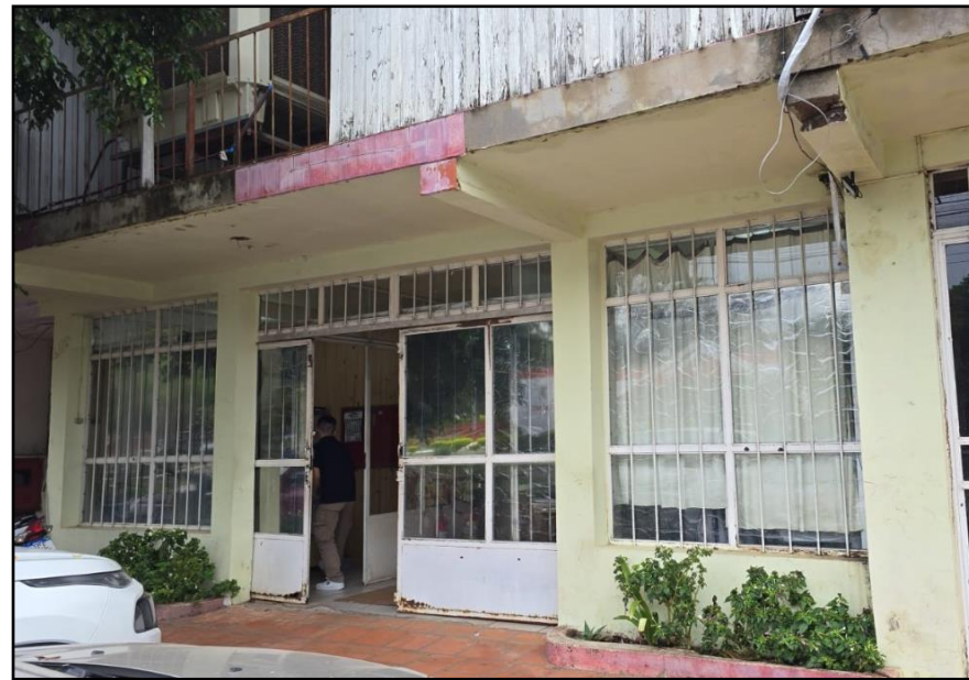
01. Fachada da Fábrica
