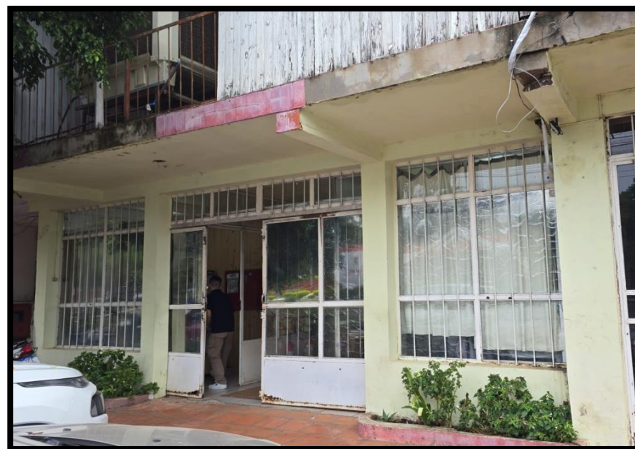
01. Fachada da Fábrica
