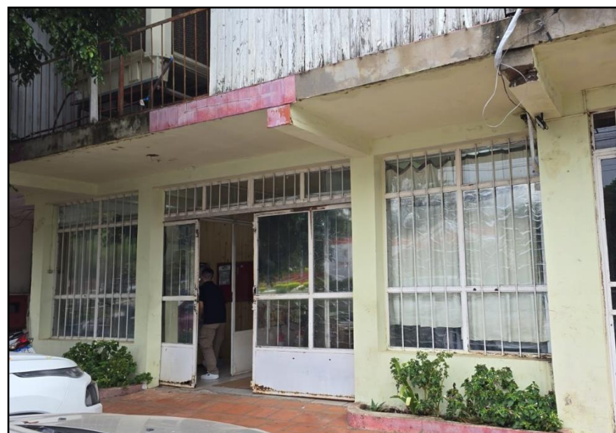
01. Fachada da Fábrica
